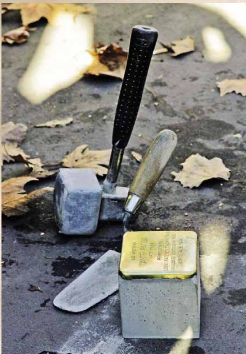
Lavori in corso per la posa di una Pietra d'Inciamo, foto Archivio Istoreco, Reggio Emilia, gennaio 2016
